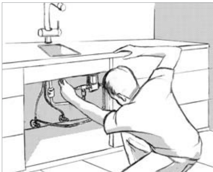
3. Schließen Sie die Armatur wie gewohnt an Ihre vorhandenen Wasseranschlüsse an. Die batteriebetriebene Steuereinheit der EasyTouch Technologie wird jetzt lediglich noch zwischen Armaturen- und Kaltwasseranschluss geschaltet. Schon läuft's mit jeder Berührung.
